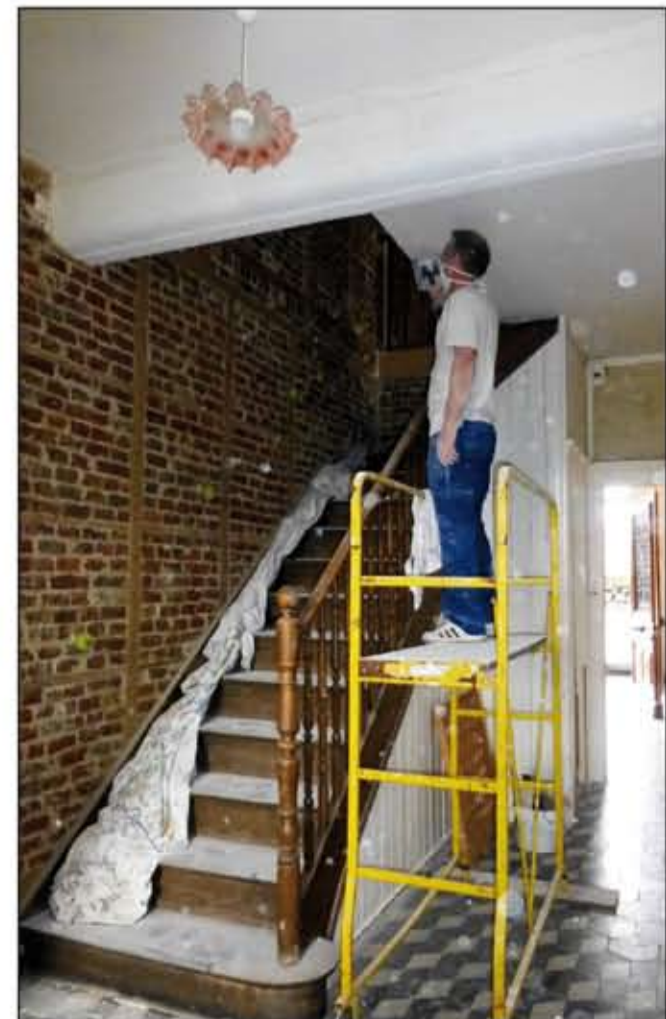
Réfection de la montée d'escalier.
